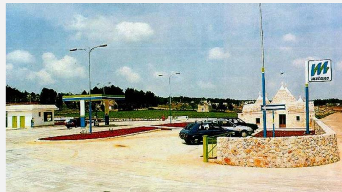
(Anni '80 - '90: stazione di rifornimento)
