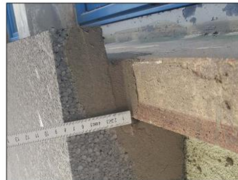
Risega del cappotto esterno in EPS grigio da 16 cm in prossimità del davanzale.
