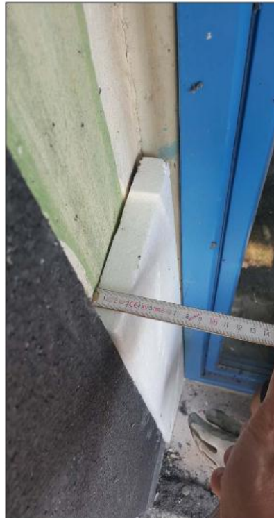
Risolvo isolante esterno in EPS bianco su spalla degli infissi, sp. 3 cm, \lambda = 0.035 \text{ W/mK}
