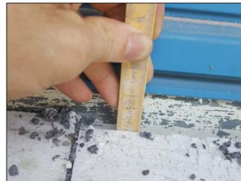
Risolvo isolante esterno in EPS bianco su davanzale, sp. 3 cm, \lambda = 0.035 \text{ W/mK}
