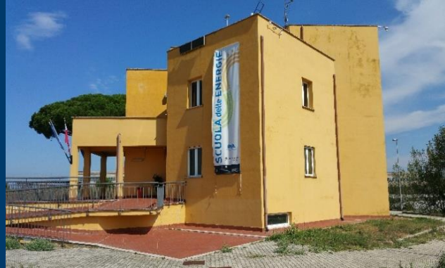
Edificio senza coltre vegetale
