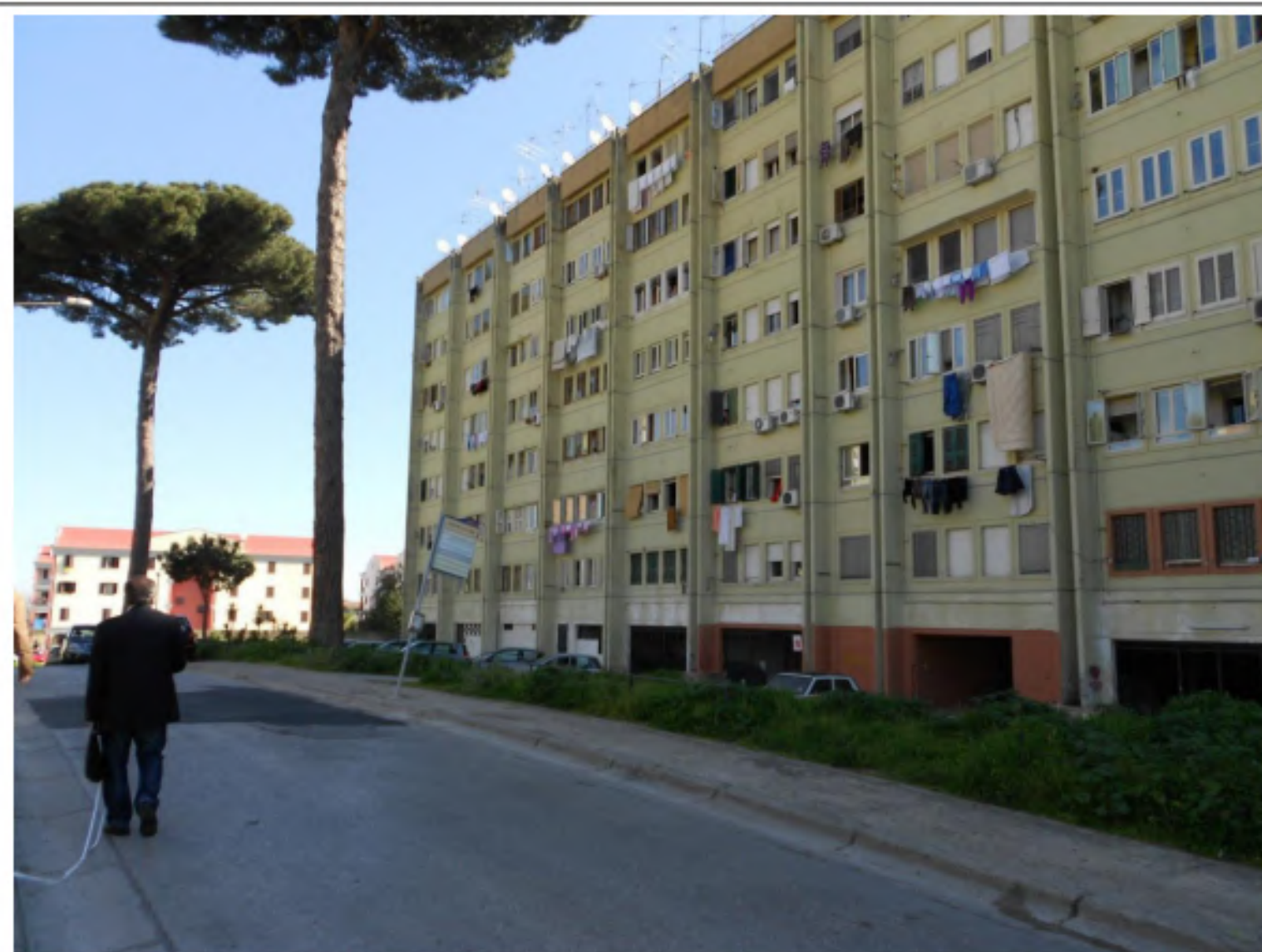
Prefabbricato da sostituire identificato con il n. 4- fronte ovest
